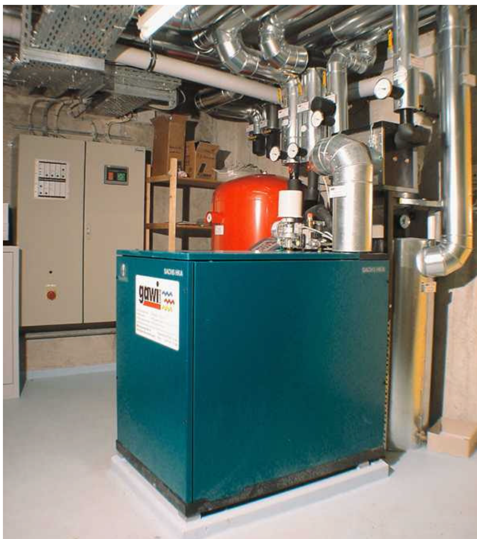
Abb. 7: BHKW / Passivhaus - Wohnen & Arbeiten
